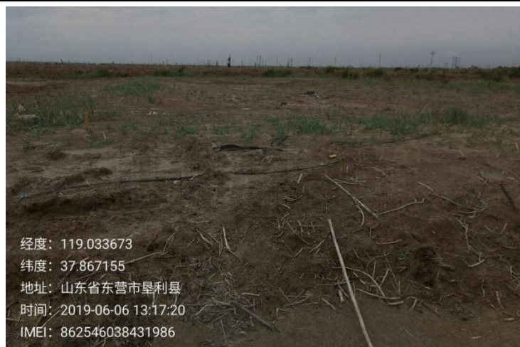
泥浆池固化覆土后照片
